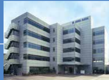
株式会社アバールデータ 本社・町田事業所 AVAL DATA head office
